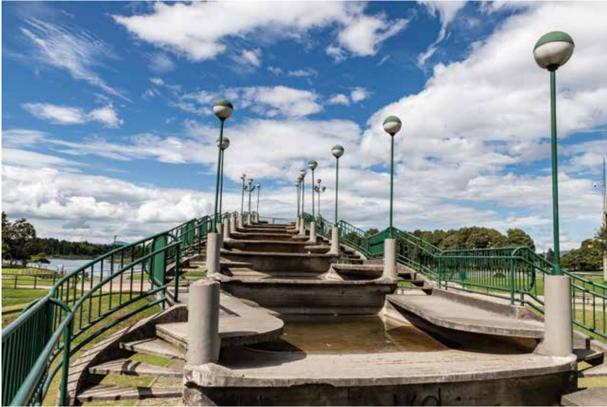
Vista superior de la fuente mirador. 2019. Fotografía: Carlos López-IDPC
