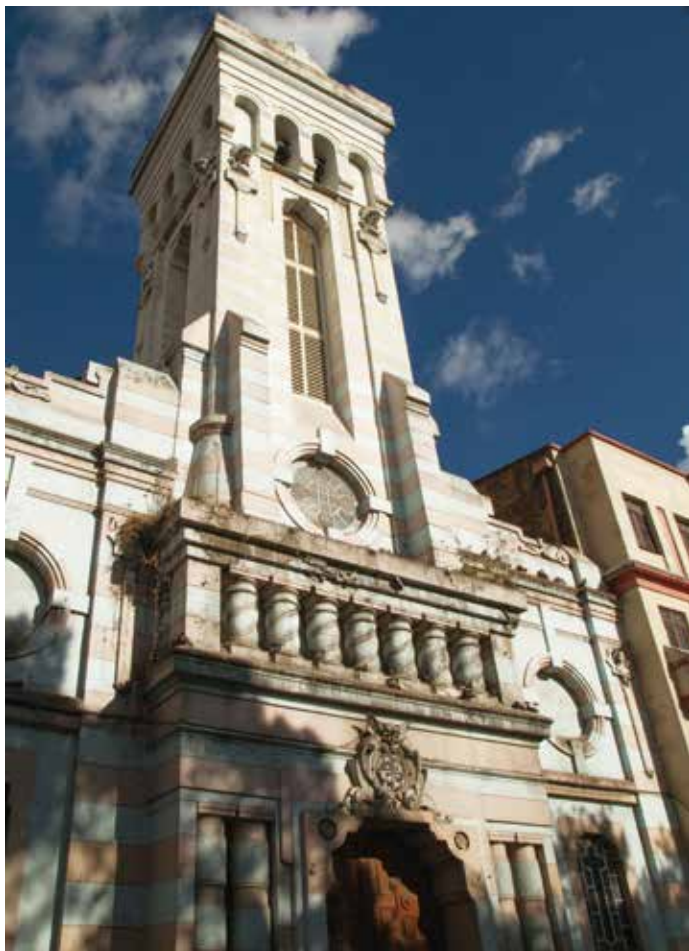
Vista general de la fachada principal sobre la carrera 7.ª. 2018. Fotografía: Carlos Lema-IDPC
