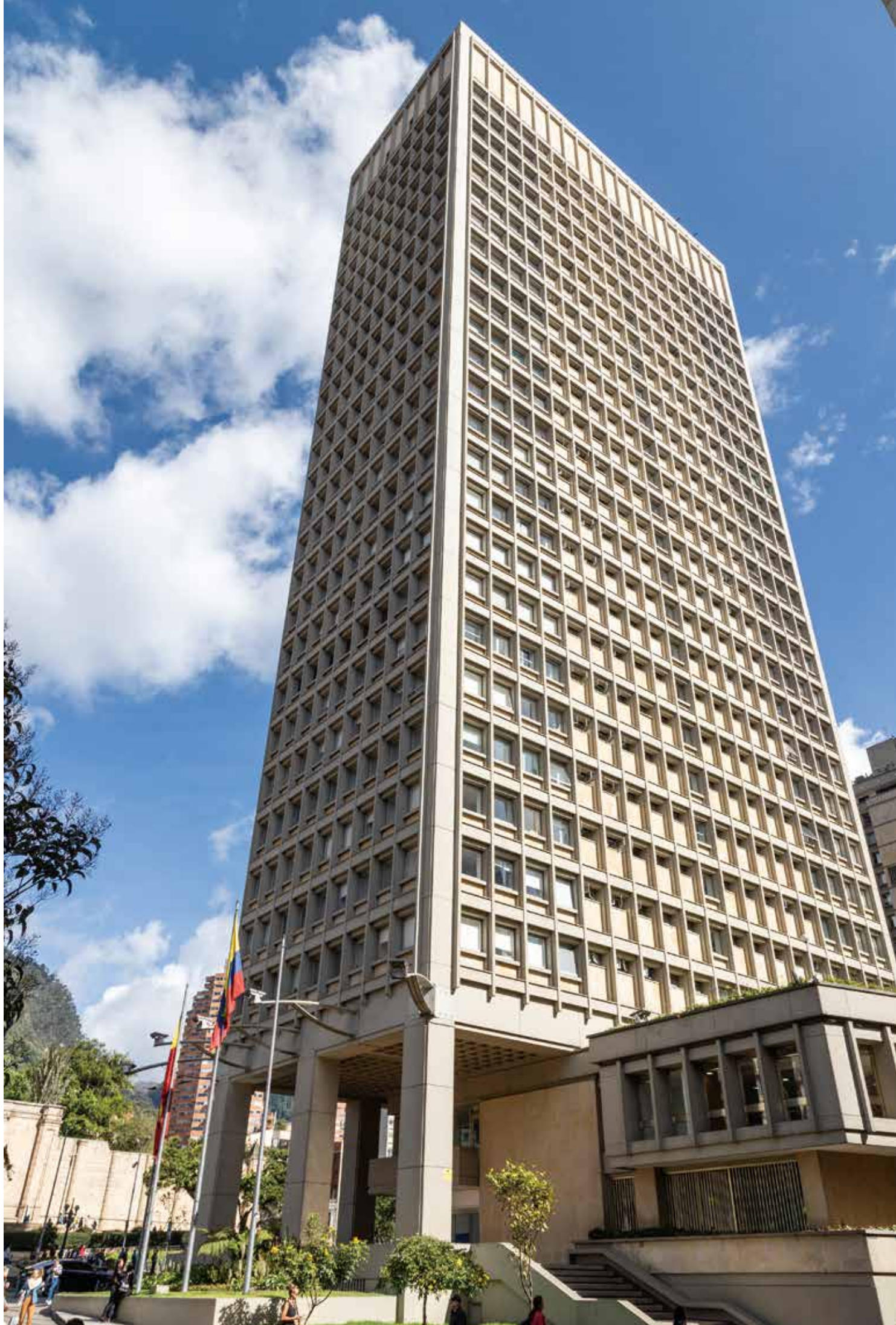
Vista de la torre del Conjunto Bavaria y su fachada con retícula modular en concreto. 2019. Fotografía: Carlos López-IDPC
