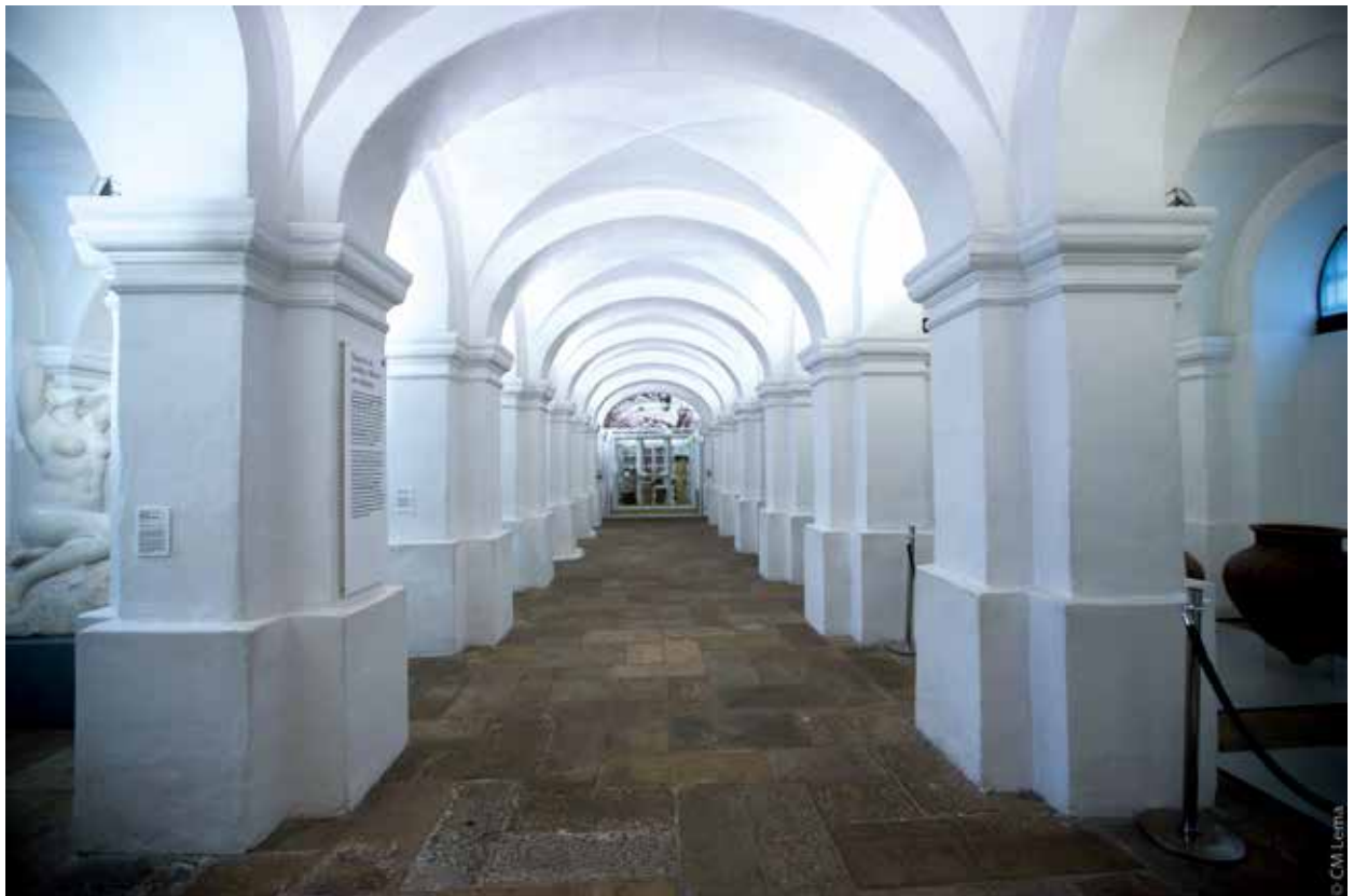
Corredor formado por arcadas y bóvedas con arcos de medio punto. 2016. Fotografía: Carlos Lema-IDPC
