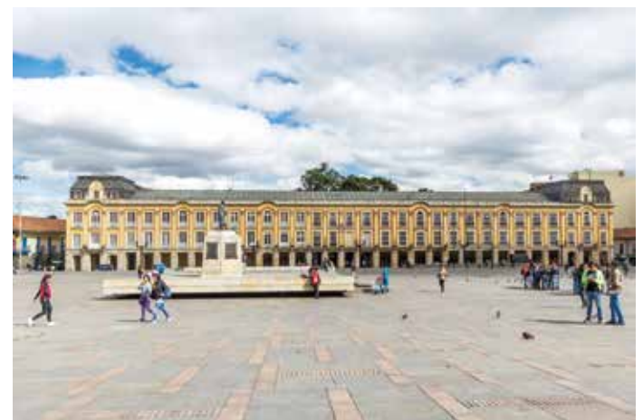
Fachada principal del palacio desde la plaza de Bolívar. 2019. Fotografía: Carlos López-IDPC
