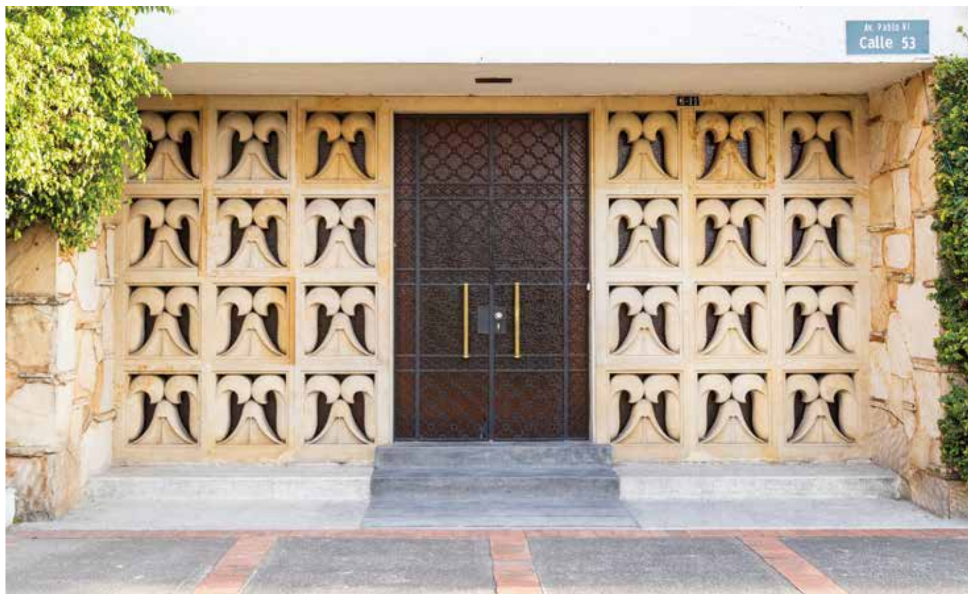
Detalle de acceso principal al inmueble con puerta de hierro forjado y elementos decorativos en piedra. 2019. Fotografía: Carlos López-IDPC
