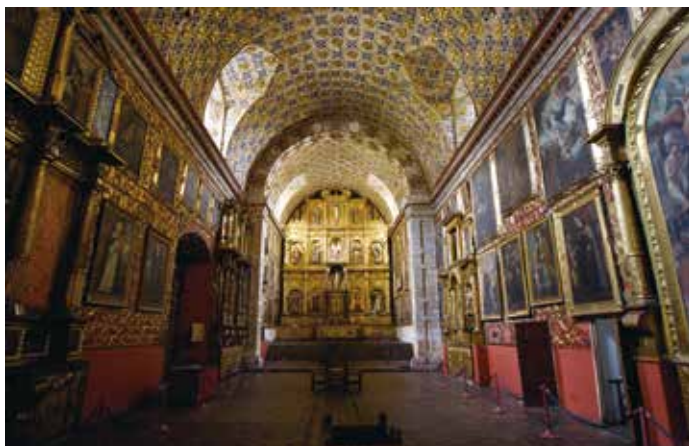
Interior de la nave cubierta por la bóveda de cañón con lunetos, 2019. Fotografía: Carlos Lema-IDPC
