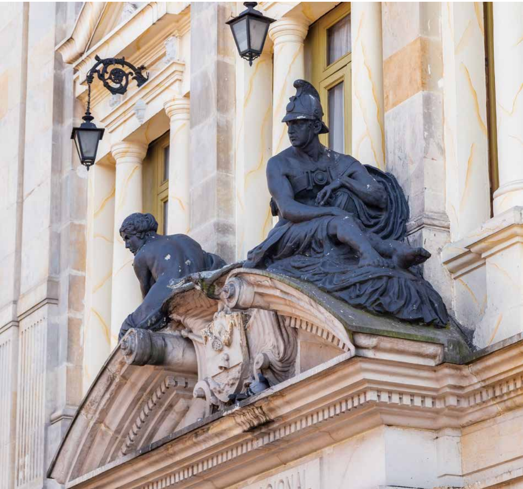
Vista superior de las fachadas principal. 2019. Fotografía: Carlos López - IDPC
