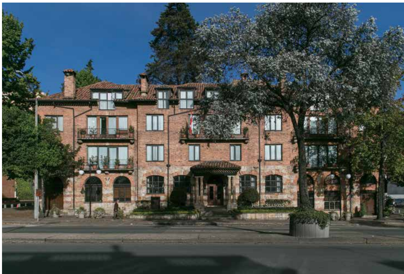
Vista frontal del inmueble luego de ser adecuado para el Hotel Four Seasons. 2019. Fotografía: Carlos Lema-IDPC
