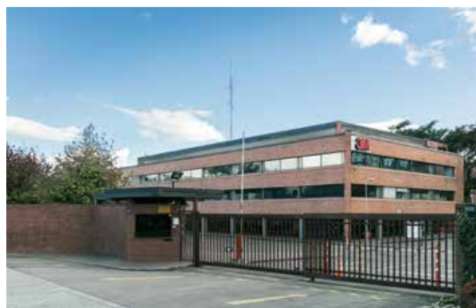
Vista del edificio desde la calle 26. 2019. Fotografía: Carlos Lema-IDPC
