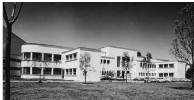
Vista general del edificio de composición simétrica y esquinas laterales redondeadas.1973. Fondo Germán Téllez (MdB05992), colección Museo de Bogotá
