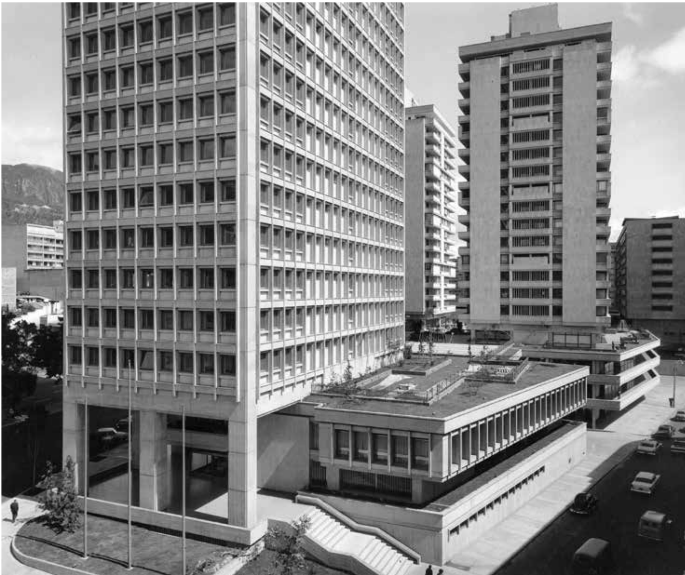
Vista de la plataforma que conecta la carrera 10ª con la carrera 7ª a través de circulaciones horizontales y parte inferior de la torre del conjunto. 1966. Fondo Paul Beer (MdB24764), colección Museo de Bogotá
