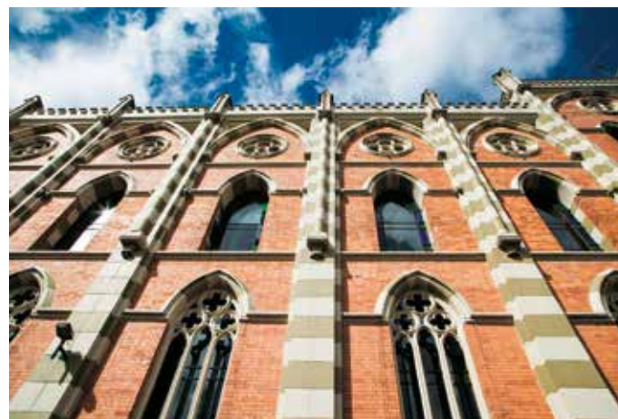
Vista superior de la fachada donde resalta la secuencia de pilastras y ventanales con arcos ojivales. 2015. Fotografía: Margarita Mejía-IDPC
