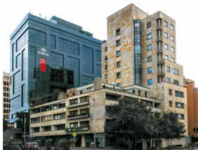
Vista general del edificio, actualmente con uso de oficinas y establecimientos comerciales. 2019. Fotografía: Carlos Lema-IDPC
