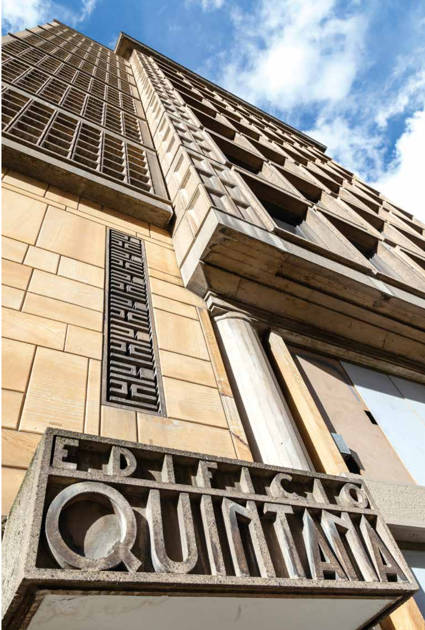
Detalle de la portada de acceso con elementos decorativos en concreto. 2019. Fotografía: Carlos López-IDPC
