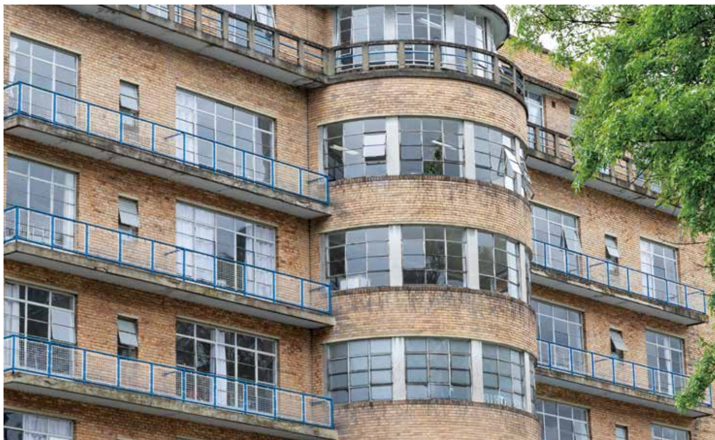
Detalle de la ventanería y muro curvo con circulación vertical. 2019. Fotografía: Carlos López–IDPC
