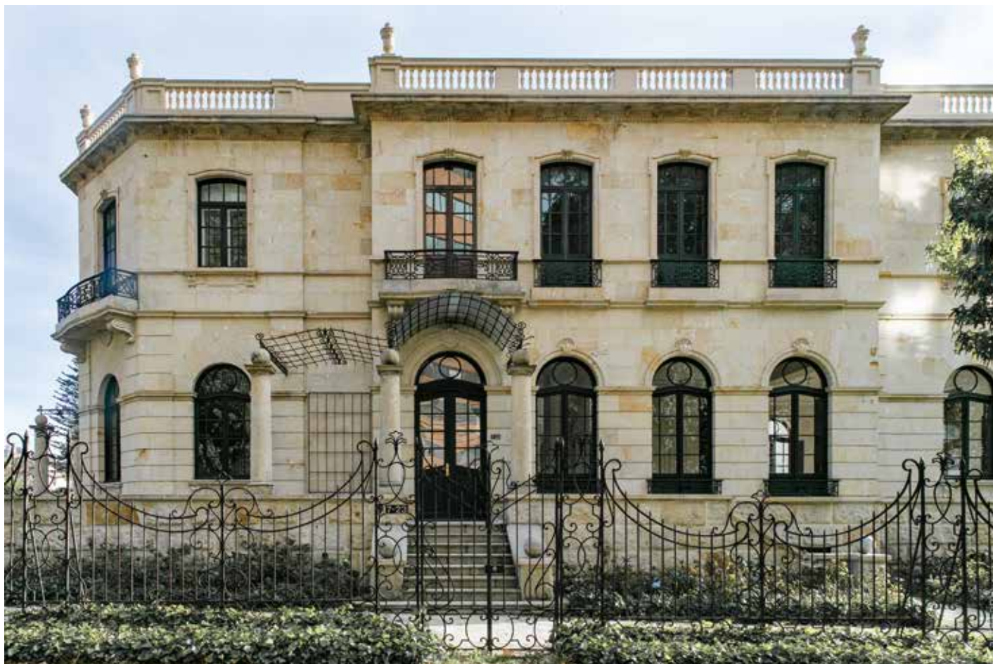
Vista de la fachada de acceso en donde se aprecia el delicado forjado de las carpinterías metálicas. 2019. Fotografía: Carlos Lema-IDPC
