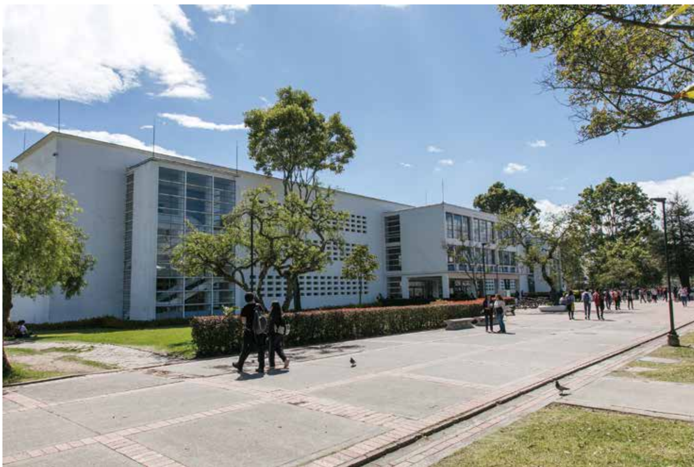
Vista general del edificio emplazado a lo largo del sendero peatonal. 2019. Fotografía: Carlos Lema-IDPC
