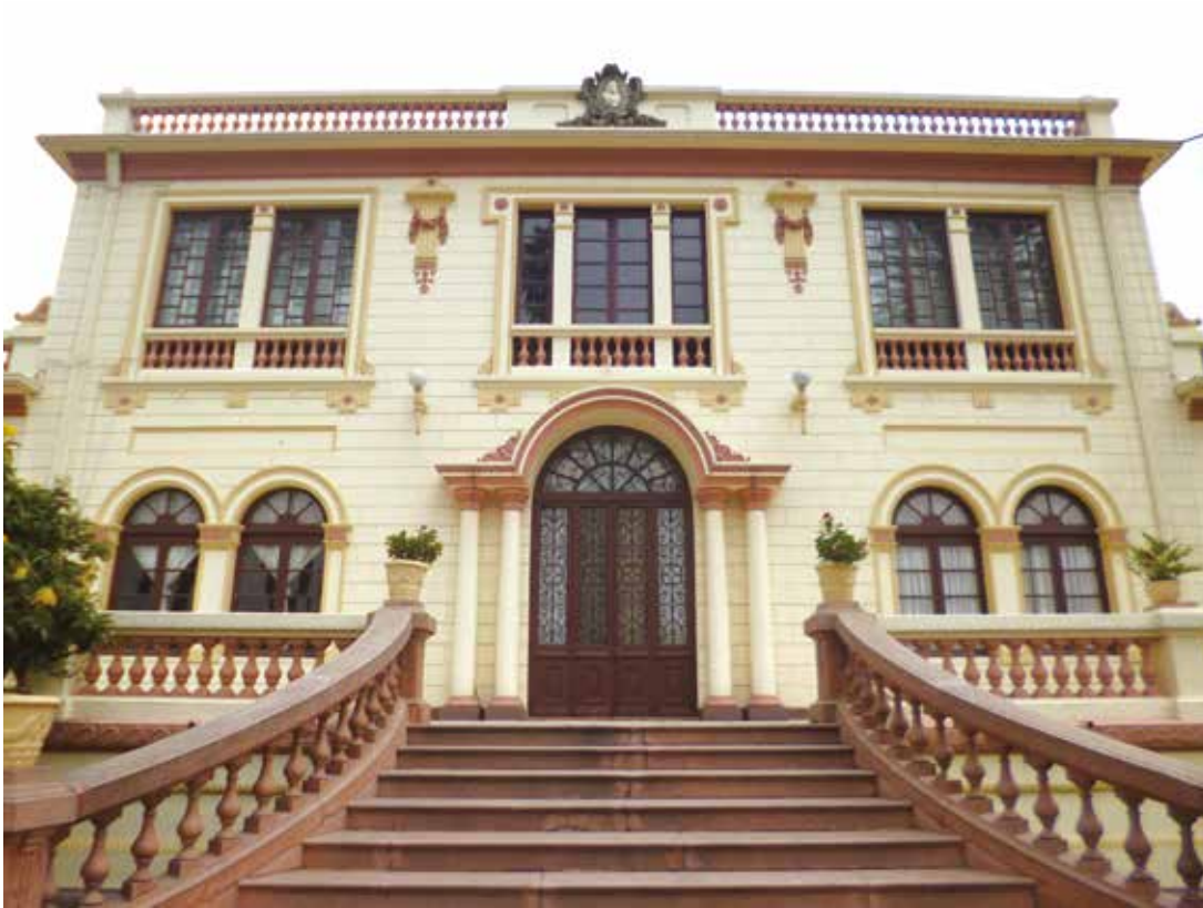
Detalle del acceso principal entre columnas dobles y arco de medio punto. 2011. Fotografía: Alexander Vallejo-IDPC
