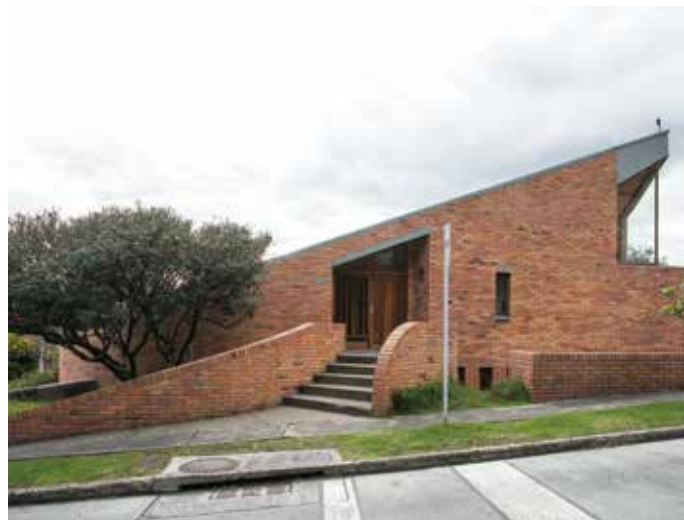
Vista del acceso principal retrocedido en el cuerpo superior de la casa. 2019. Fotografía: Carlos Lema-IDPC
