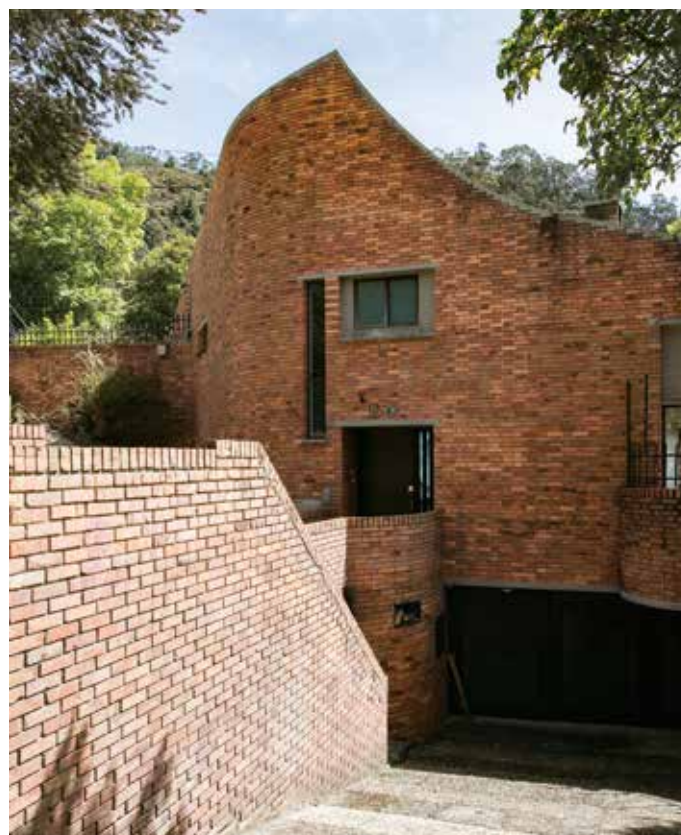
Vista de la fachada curva del acceso principal y acceso al parqueadero. 2019. Fotografía: Carlos Lema-IDPC
