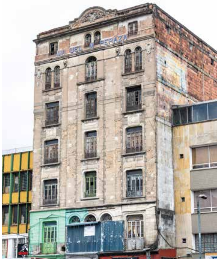
Fachada del edificio Manuel Peraza. 2019. Fotografía: Carlos López-IDPC
