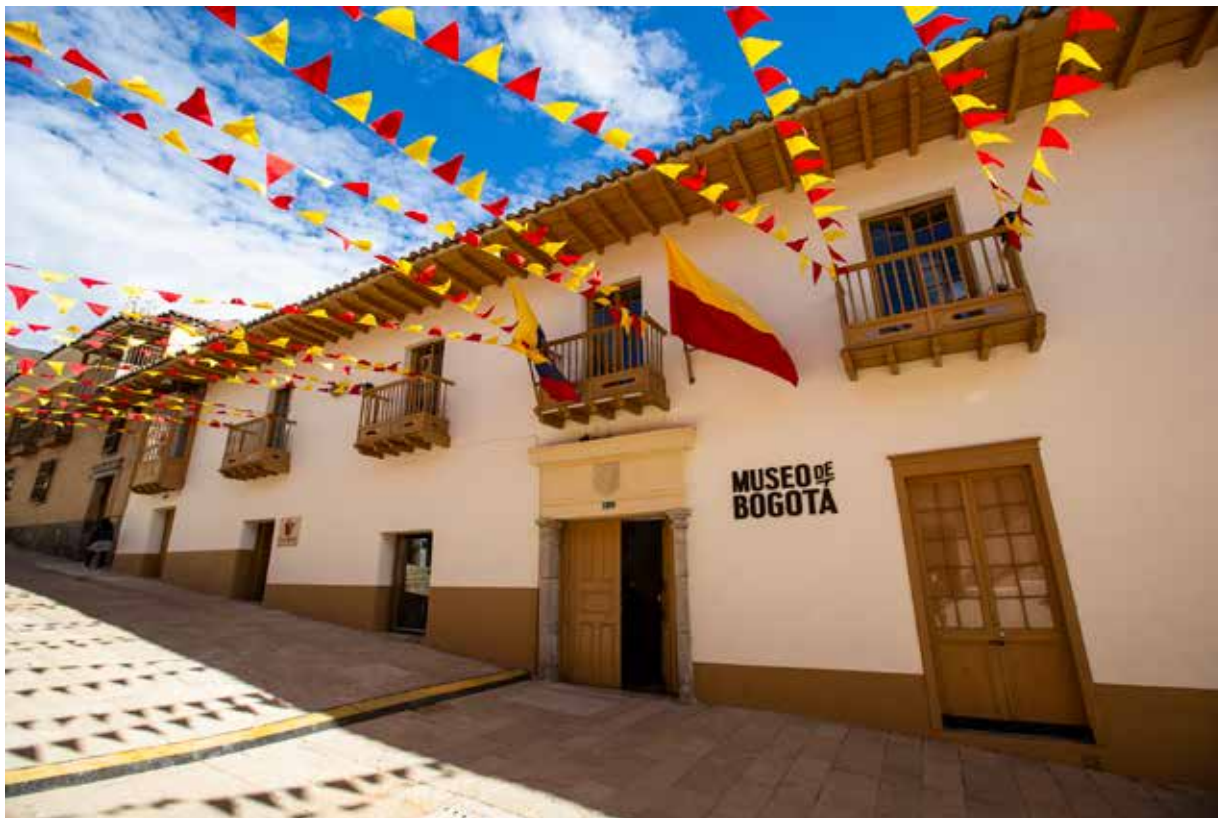
Fachada principal de la casa, sede los Siete Balcones. 2019. Fotografía: Carlos López-IDPC
