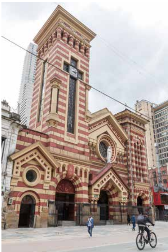
Fachada principal de la iglesia. 2019. Fotografía: Carlos López-IDPC
