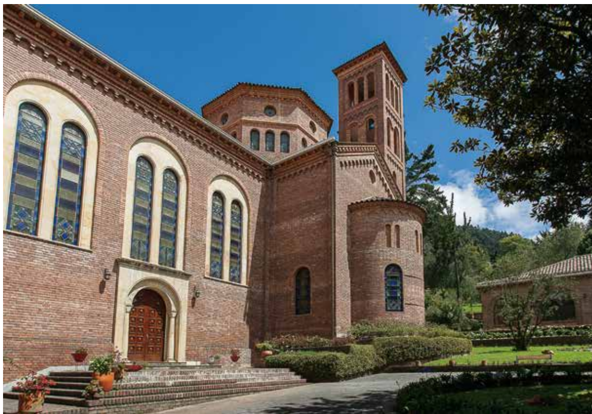
Fachada lateral de la iglesia en ladrillo con vitrales y al fondo, la torre cuadrada y el cimborrio octogonal. 2019. Fotografía: Carlos Lema-IDPC
