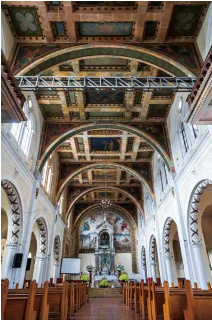
Nave central y cielo raso plano en madera decorado. 2019. Fotografía: Carlos López-IDPC
