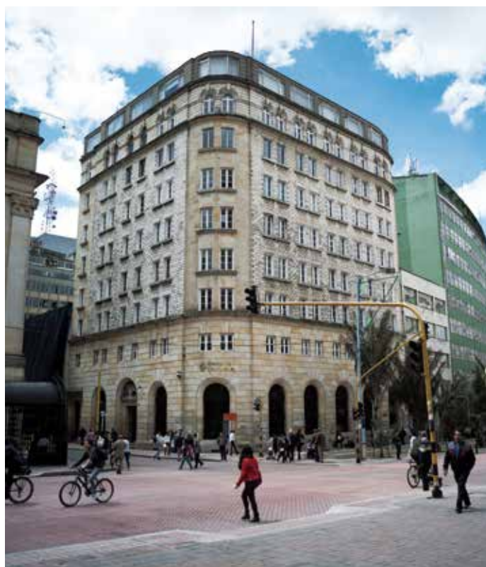
Vista general del edificio desde la Av. Jiménez en donde se aprecia la esquina rebajada con el acceso principal. 2017. Fotografía: Hanz Rippe-IDPC
