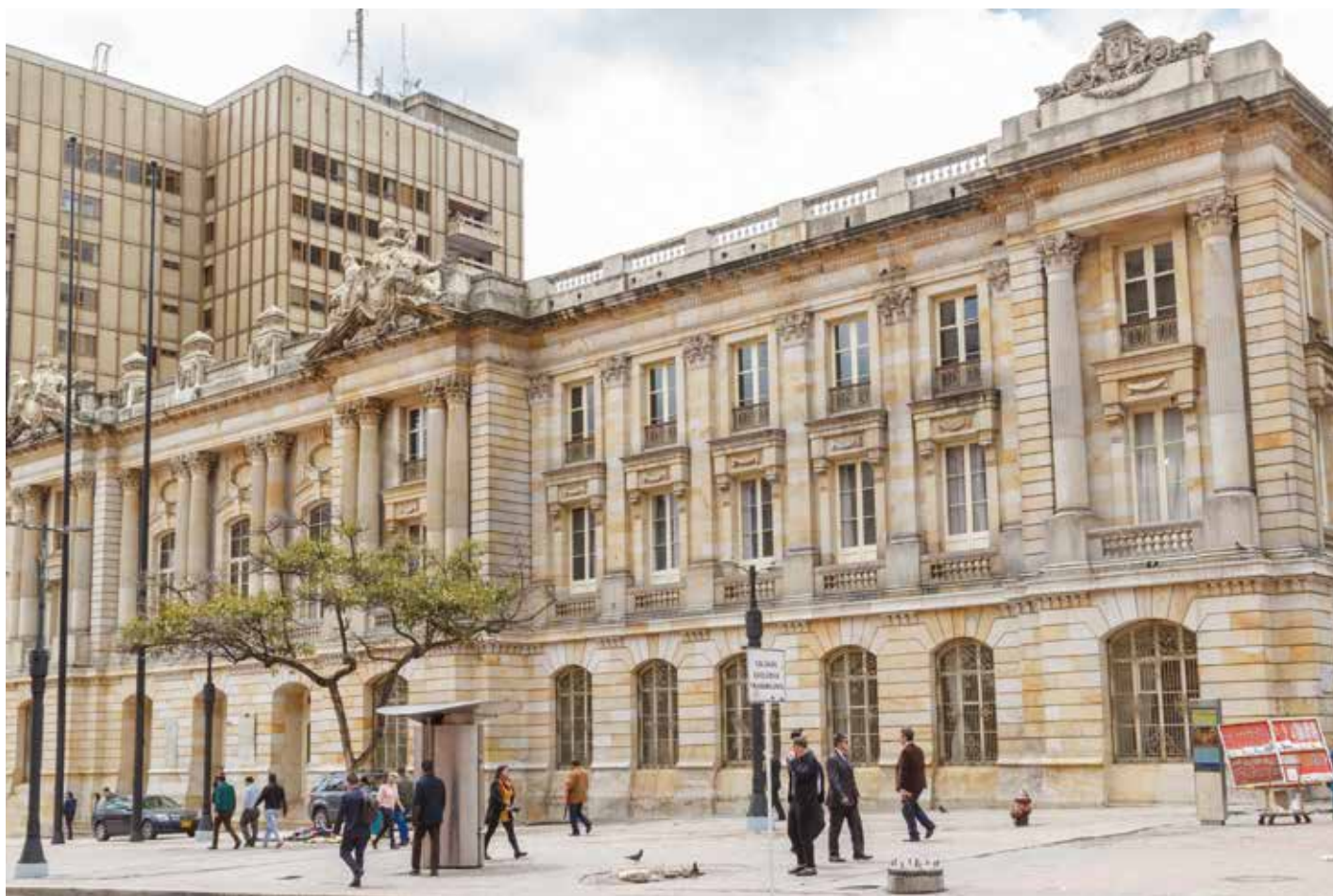
Fachada del palacio. 2019. Fotografía: Hanz Rippe-IDPC
