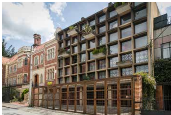
Vista general de la fachada del edificio de composición reticular en concreto. 2019. Fotografía: Carlos Lema-IDPC
