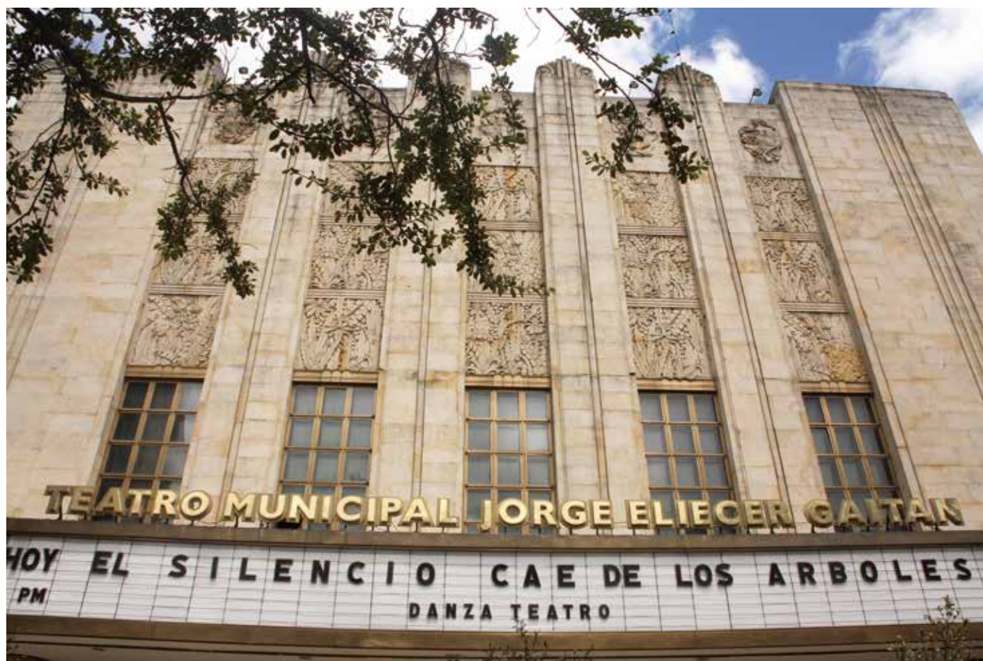
Vista superior de la fachada en donde resaltan los relieves del escultor Bernardo Vieco. 2012. Fotografía: Margarita Mejía-IDPC
