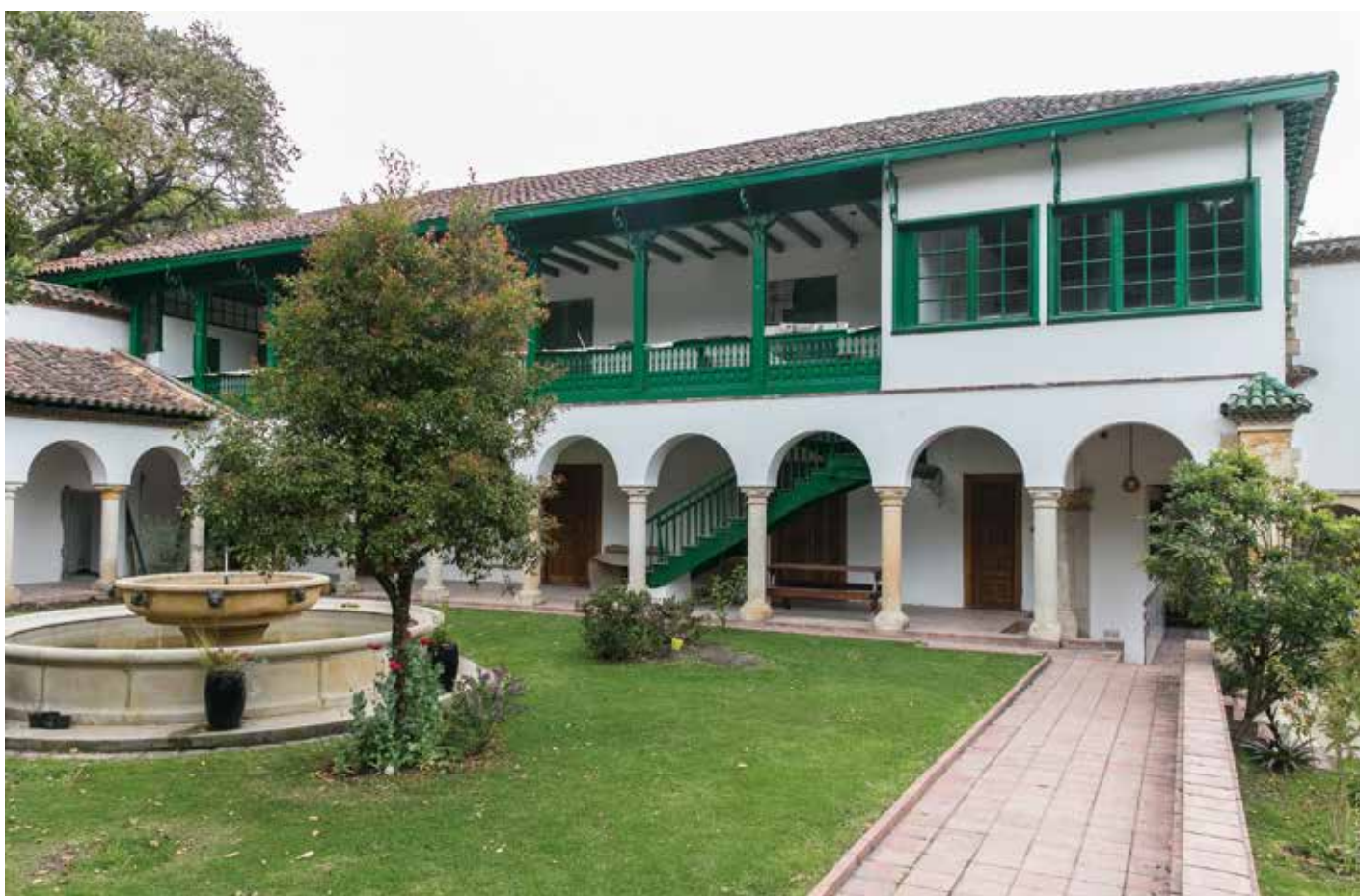
Patio central con vista hacia la arcada perimetral y corredor superior. 2019. Fotografía: Carlos Lema-IDPC
