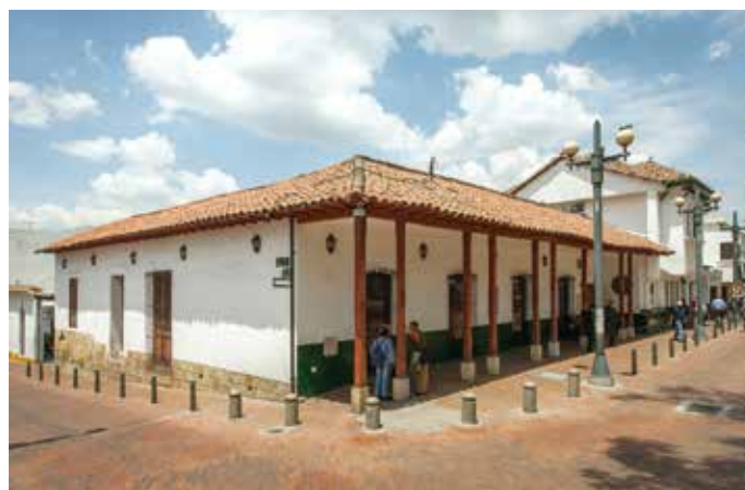
Vista de la actual Alcaldía Local ubicada en el costado occidental de la plaza. 2019. Fotografía: Carlos Lema-IDPC
