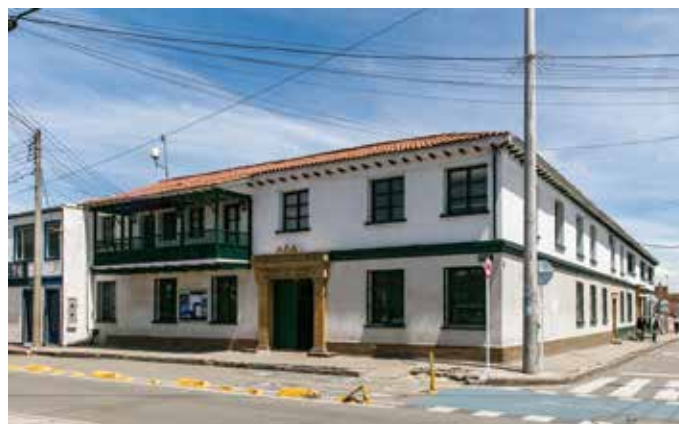
Casa de la Alcaldía Local de Bosa con portada central en piedra y destacado balcón lateral en madera. 2019. Fotografía: Carlos Lema-IDPC
