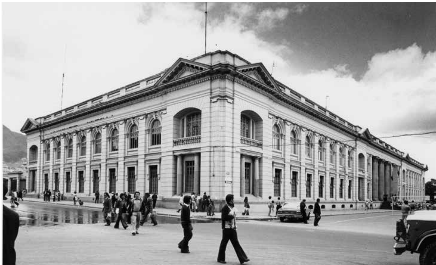
Vista de la esquina del edificio que remata en frontones clásicos y contiene balcones de arco rebajado sostenidos por columnas dóricas. 1975. Fondo Germán Téllez (MdBC06082). Colección Museo de Bogotá
