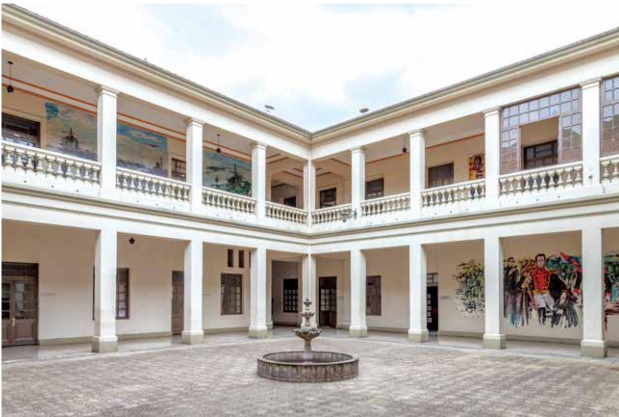
Patio interior con circulaciones perimetrales en dos niveles. 2018. Fotografía: Hanz Rippe-IDPC
