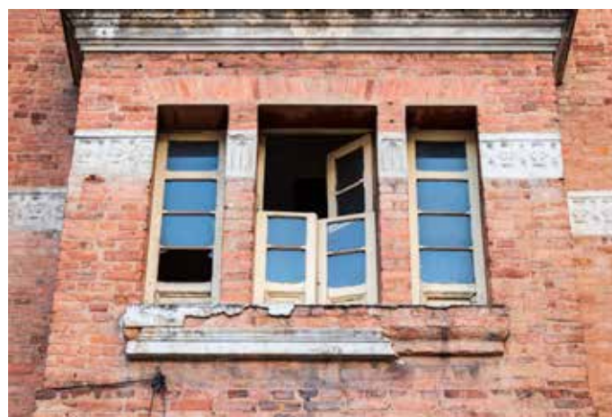
Detalle de ventana superior con alfaja en ladrillo revestido de yeso. 2019. Fotografía: Carlos López-IDPC
