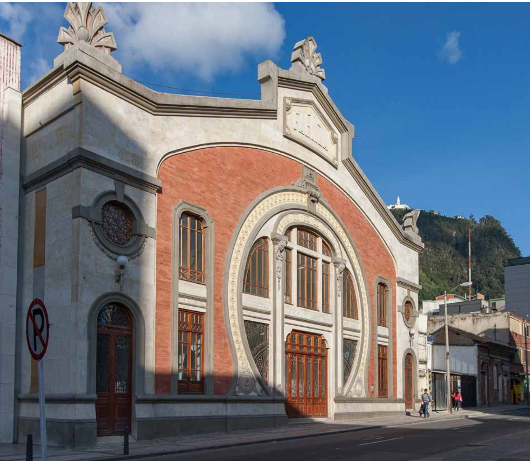
Fachada principal del Teatro Faenza. 2019. Fotografía: Carlos Lema-IDPC
