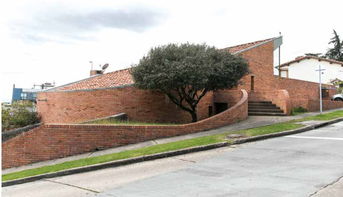
Vista general del inmueble con destacado muro de cubierta inclinada. 2019. Fotografía: Carlos Lema-IDPC
