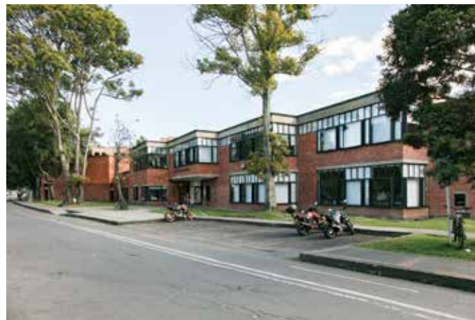
Fachada del edificio sobre una de las vías interiores., 2019. Fotografía: Carlos Lema-IDPC
