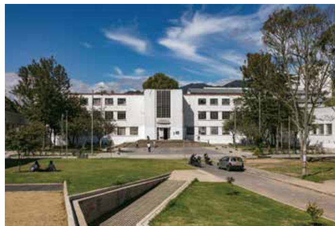
Fachada suroccidental de acceso con sobresaliente cuerpo central elevado. 2019. Fotografía: Carlos Lema-IDPC
