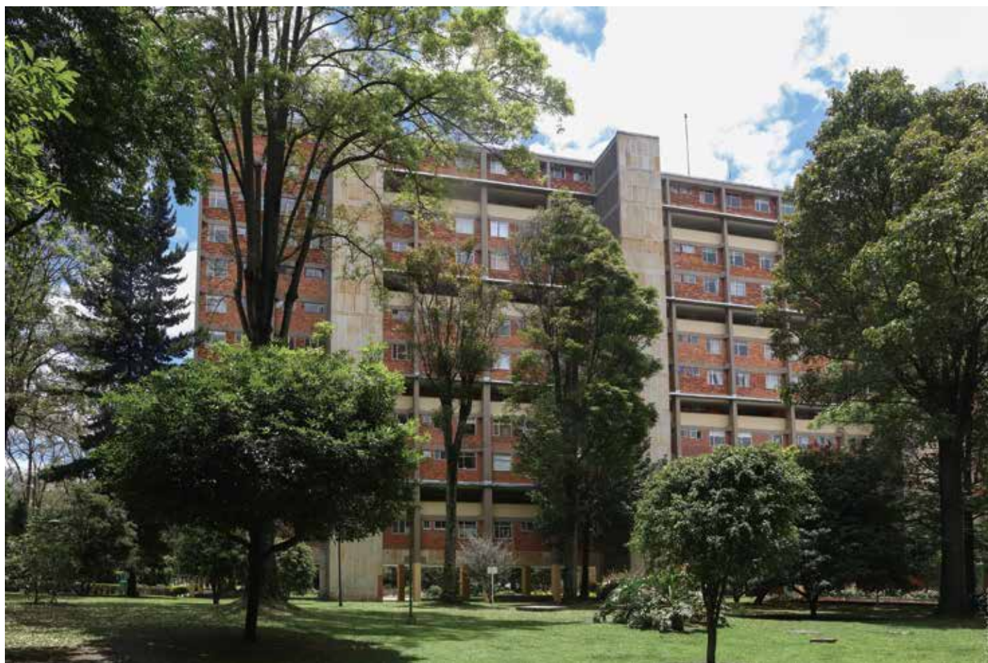
Vista general de una torre con destacada planta libre en el primer nivel y volúmenes adosados para la circulación vertical. 2019. Fotografía: Carlos Lema-IDPC
