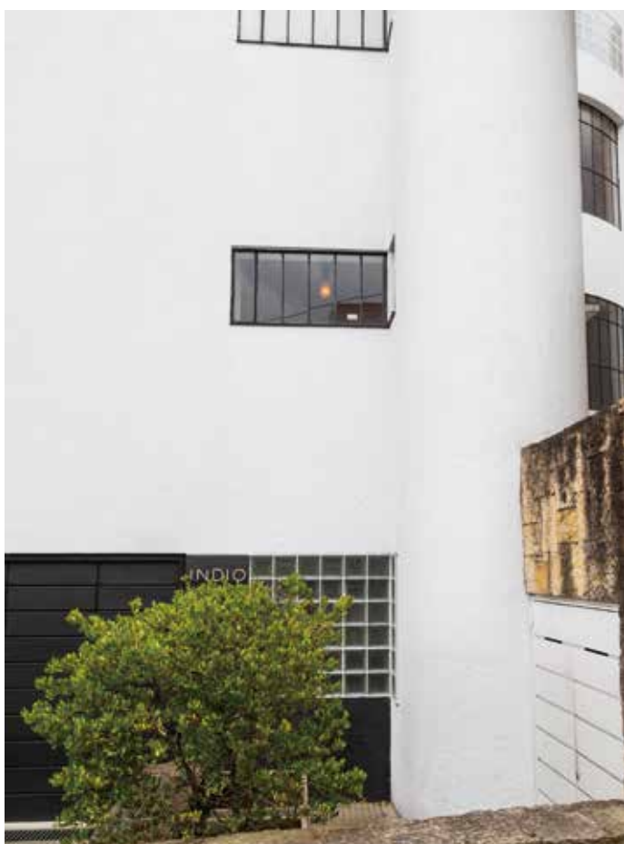
Detalle del volumen de la circulación y ventanería metálica. 2019. Fotografía: Carlos López - IDPC
