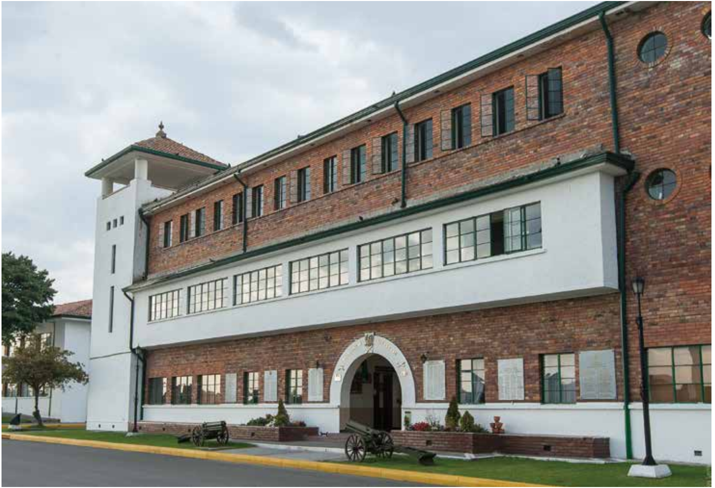
Fachada principal del Batallón de Alféreces con torre adosada lateralmente y con acceso al vestíbulo con forma de arco. 2019. Fotografía: Carlos Lema-IDPC
