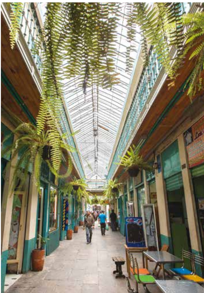
Interior del pasaje y balcones perimetrales. 2019. Fotografía: Carlos Lema-IDPC
