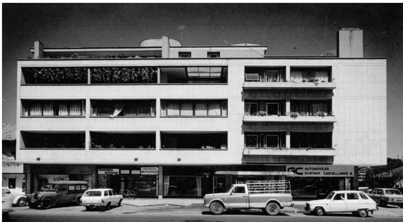
Fachada principal del edificio. 1975. Fondo Germán Téllez (MdBC06068). Colección Museo de Bogotá
