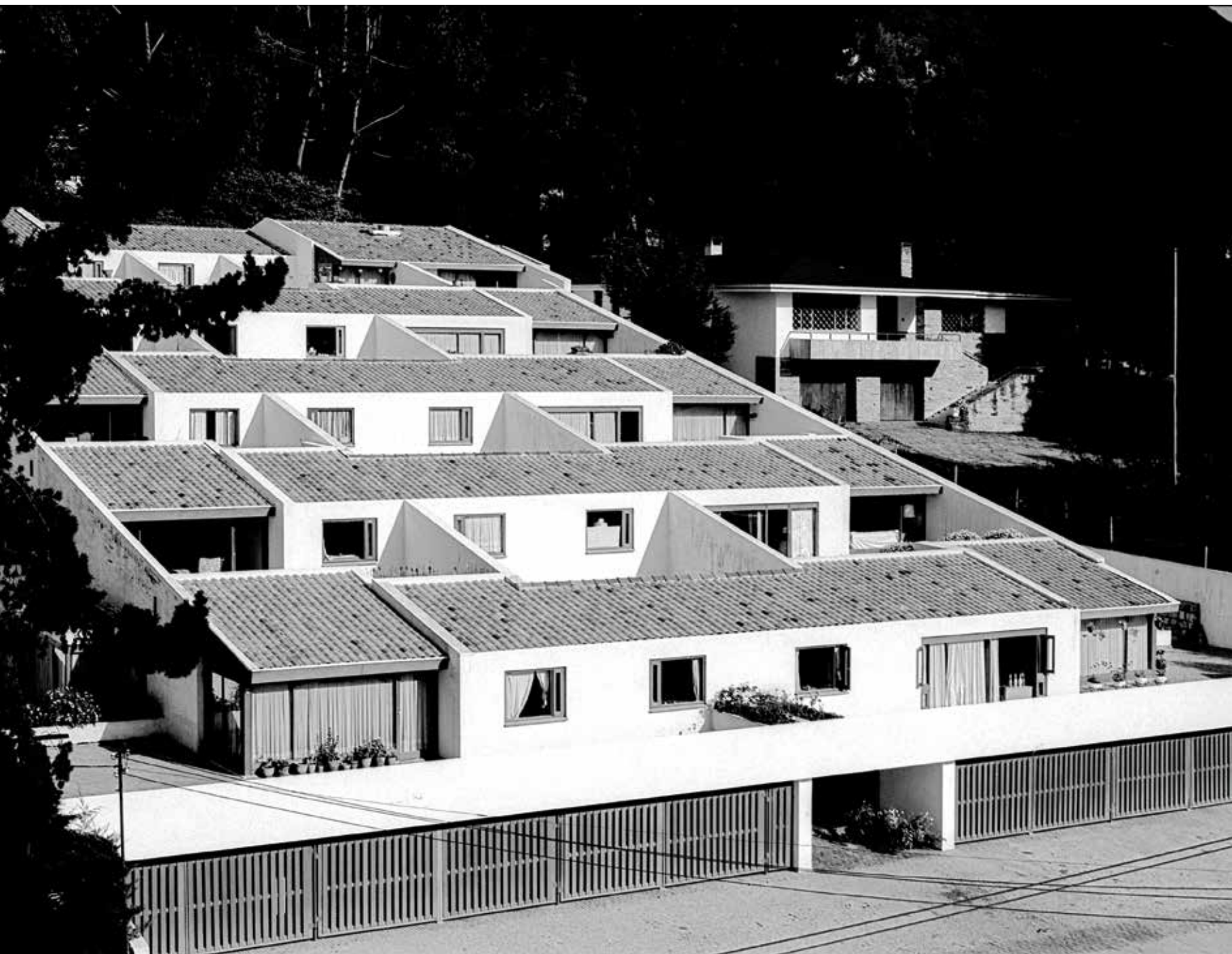
Vista general en donde se aprecia la composición de los patios interiores. 1981. Fondo Germán Téllez (MdB06225). Colección Museo de Bogotá
