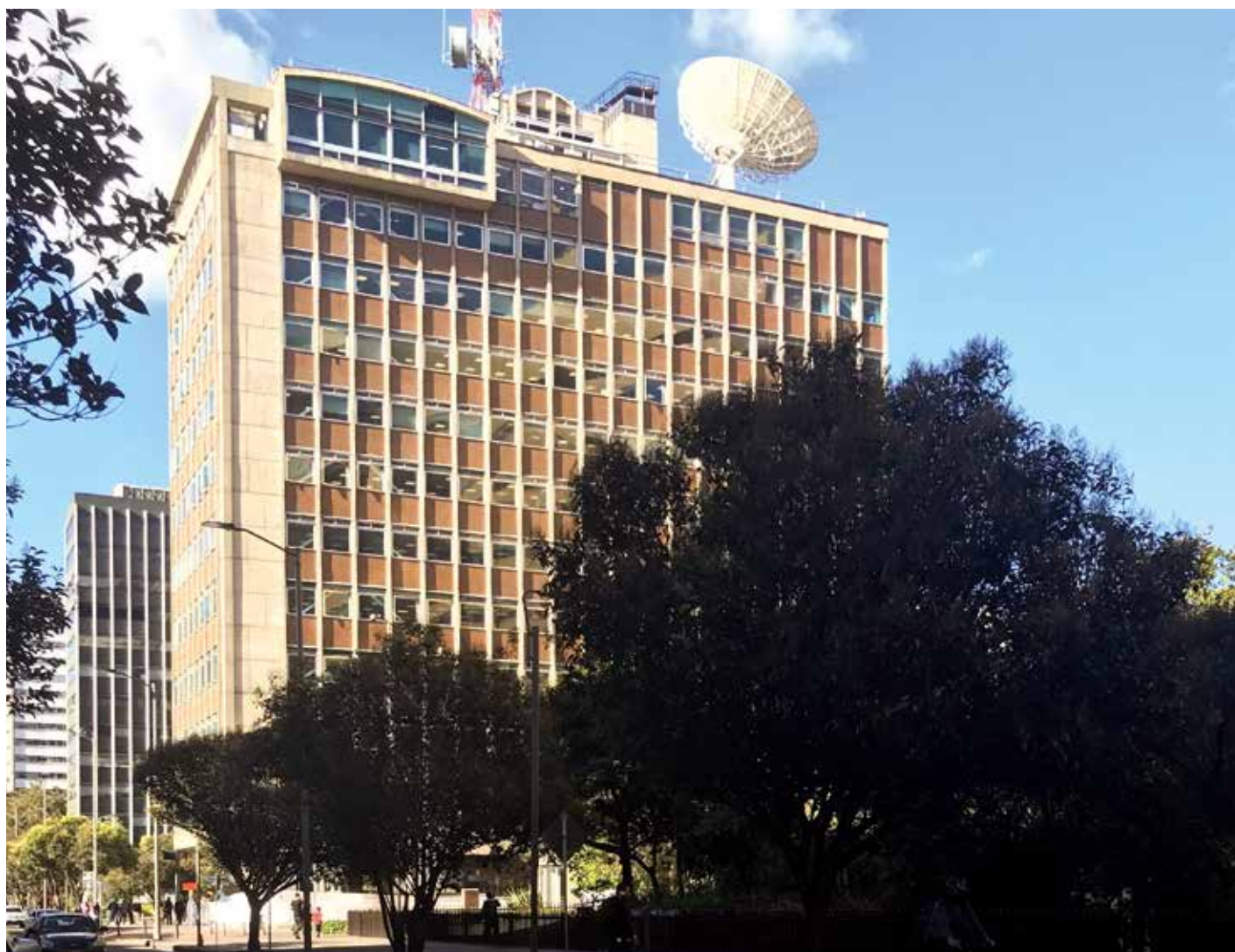
Vista oblicua del Edificio Ecopetrol desde la carrera 13, en donde sobresale la fachada modular construida en gran parte con elementos prefabricados en concreto. Fotografía: cortesía Carlos Niño Murcia
