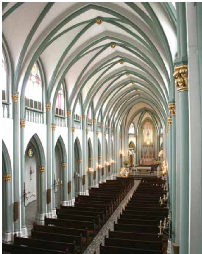
Nave central de la capilla de San Façon de gran altura con una bóveda de crucería y arcos ojivales. 2012. Fotografía: Mauricio Uribe González
