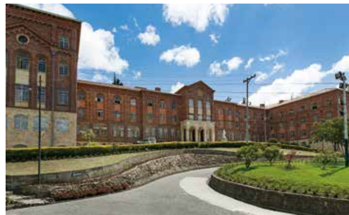
Vista general de la fachada principal del edificio; se destaca el cuerpo central de acceso. 2019. Fotografía: Carlos Lema-IDPC
