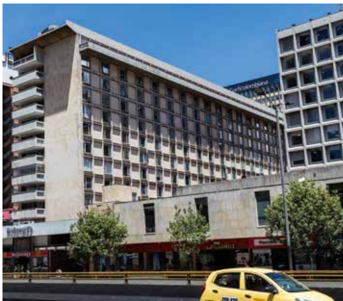
Fachada del edificio en donde se puede observar una estricta modulación de la fachada. 2019. Fotografía: Carlos López-IDPC
