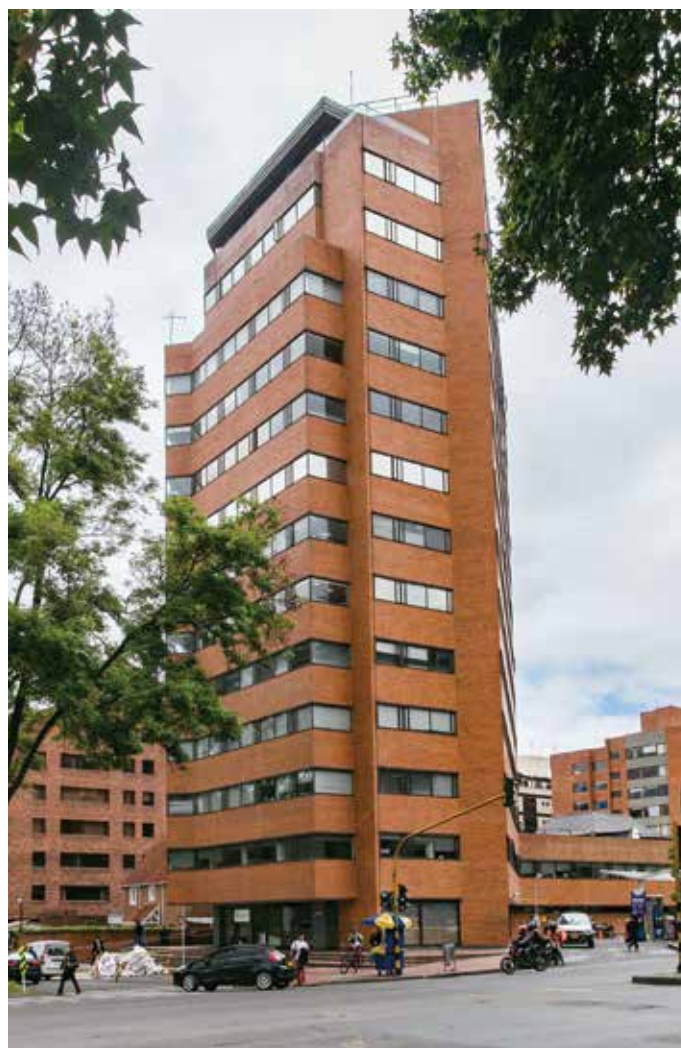
Vista oblicua de la torre de oficinas que enfatiza los acentos volumétricos y la preponderancia de los muros en ladrillo como elemento compositivo en sus fachadas. 2019. Fotografía: Carlos Lema-IDPC
