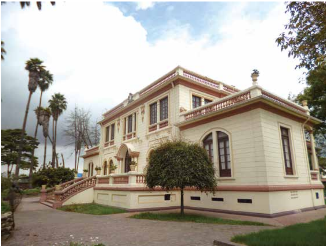
Vista general de la casa. 2011. Fotografía: Alexander Vallejo-IDPC
