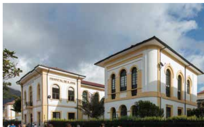
Vista actual del hospital que mantiene en gran medida su composición original. 2017. Fotografía: Carlos Lema-IDPC
