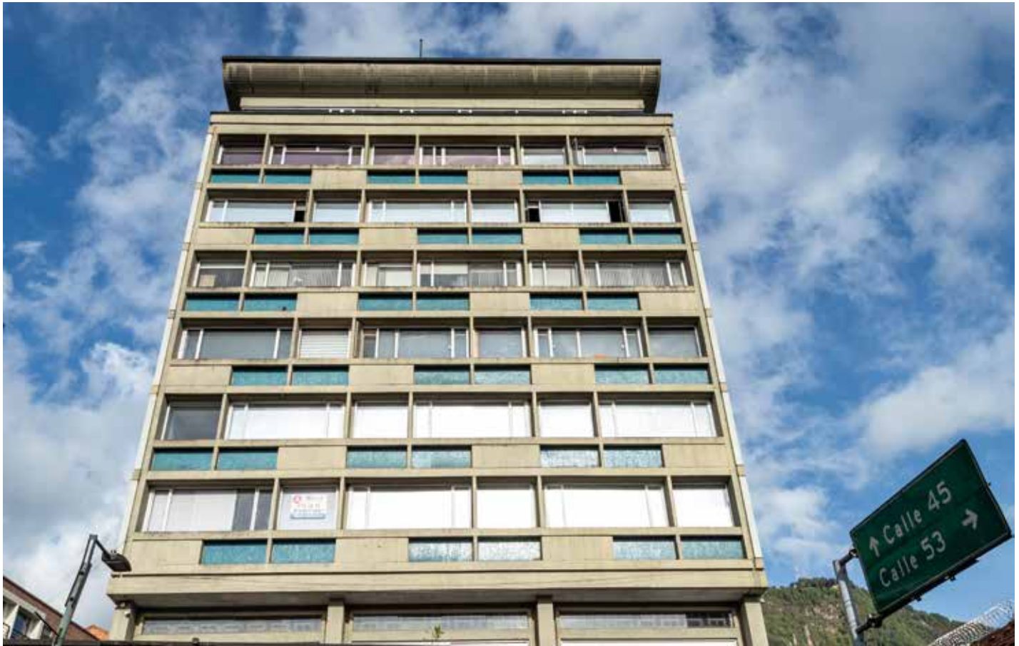
Vista fachada occidental del edificio con modulación que sigue un ritmo de geometrías ortogonales. 2019. Fotografía: Carlos López – IDPC
