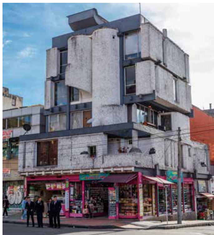
Vista exterior edificio de apartamentos en donde se aprecia el tratamiento diferenciado de cada una de sus fachadas. 2019. Fotografía: Carlos López-IDPC
